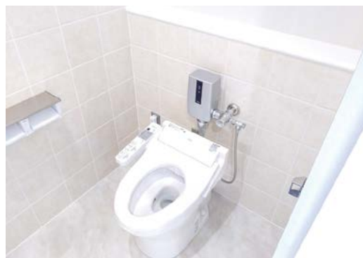
節水型トイレへの更新 （2023年度 経済1号館 トイレ）
