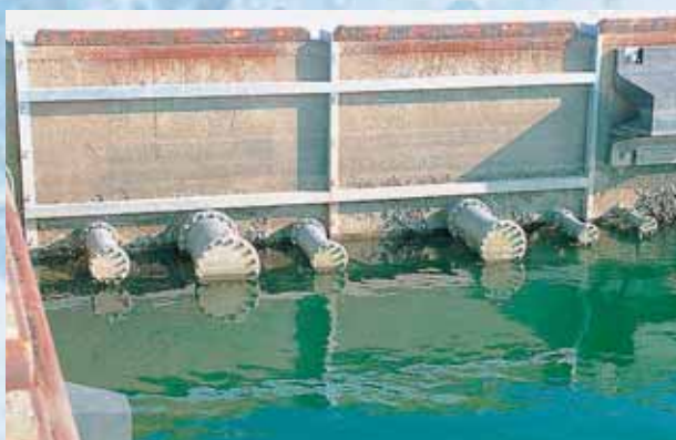
海水取水管 海洋エネルギー利用技術の研究開発では、特に実海水を使った研究が不可欠です。実海水を使った熱交換器の生物汚れ、温度変動の影響、実海水から淡水化、実海水からのリチウム回収などの研究のために、1日約1,000トンの水を汲み上げることが可能です。
